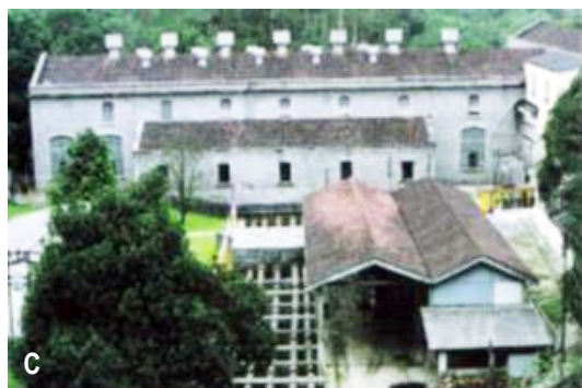
FIGURA 4. A) UHE Socorro, Socorro. B) UHE Rio Novo, Avaré. C) UHE Itatinga, Bertioga. FONTE: Amaral (2000).
