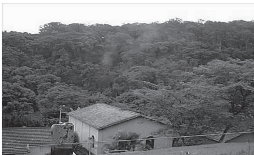
Fig. 3. Central de Monjolinho de 1893, São Carlos [SP], Brasil. Edificação típica das primeiras centrais hidrelétricas; assemelha-se muito as tulhas ou paióis rurais. / DÉBORA MORTATI, 2002
