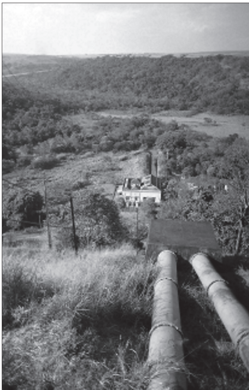
Fig. 2: Central de Capão Preto, em São Carlos [SP], Brasil. / DÉBORA MORTATI, 2000
